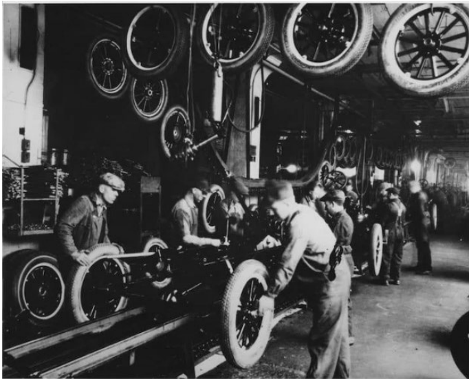
Rajah 1.4: Pekerja memasang tayar pada barisan pemasangan Ford Model T di Highland Park Plant, sekitar tahun 1925. Imej digunakan ihsan The Henry Ford ( Sumber: automasi kawalan )
